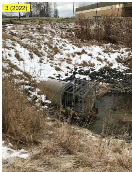
Figur 6 Intagsburen till Kretslopp och vattens dagvattenledningsnät. Dikets utlopp.
